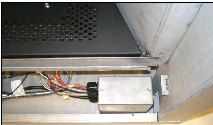
Module de contrôle de l'événement installé dans le foyer (VUE DE DESSUS).
