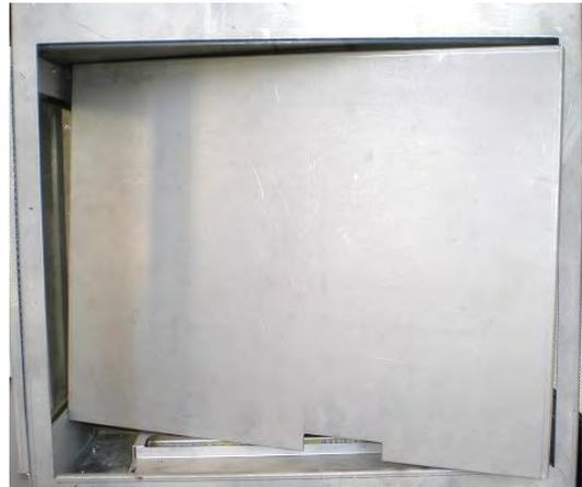
2. Inclinez la doublure arrière légèrement vers l'arrière et faites entrer dans dans le foyer en commençant par un coin supérieur.
