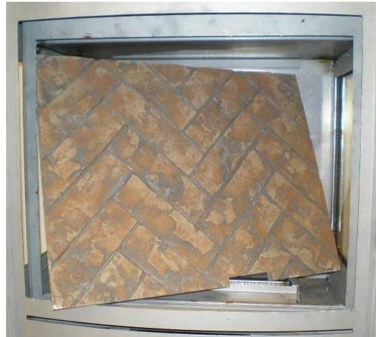
2. Inclinez la doublure arrière légèrement vers l'arrière et faites entrer dans dans le foyer en commençant par un coin supérieur.
