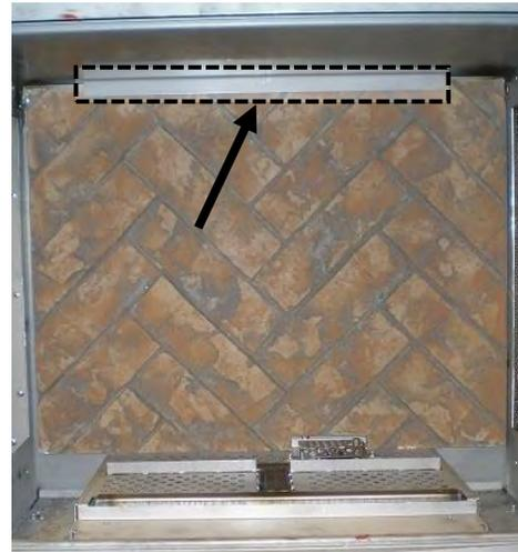
4. La doublure arrière est retenue par l'angle dans le haut du foyer.
