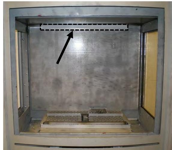
4. La doublure arrière est retenue par l'angle dans le haut du foyer.
