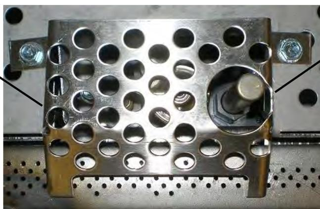
\*L'écran de veilleuse doit être inspecté visuellement une fois par mois pour voir s'il y a signe de détérioration due à l'exposition à la flamme. Remplacez si nécessaire.
