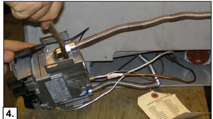
**4.** Branchez le flexible du côté entrée de la valve. Il peut être alors branché à l'alimentation en gaz et passé par le canal à l'intérieur du foyer.
