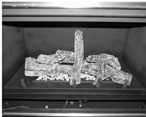
**ÉTAPE 10** - Placez la bûche 6 contre le deuxième barreau de grille à partir de la droite. La bûche 6 s'appuiera sur la bûche 2 (ne pas placer sur les ports du brûleur principal)
