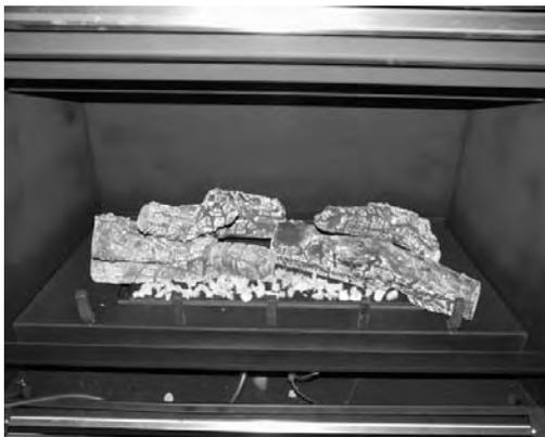
**ÉTAPE 8** - Cassez la braise incandescente en morceaux de 1/4po. Placez la braise sur le brûleur avant mais assurez-vous de ne pas recouvrir l'ouverture de l'entrée d'air qui est située entre le brûleur avant et le faux plancher.
