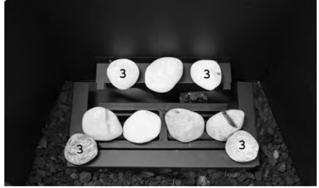
Étape 6 : Placez les pierres # 3 en place, tel qu'illustré. Ne pas placer de pierres directement sur les tubes du brûleur.
