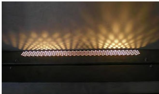
Les perforations du faux-plancher peuvent être recouvertes de verre.
