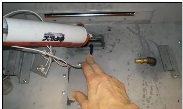
**ÉTAPE 2 :** Insérez le fils de la lampe par le trou d'accès de la chambre de combustion comme illustré ci-dessus. Appliquez du nouveau scellant (Mill-Pac). Fixez la plaque avec des vis.
