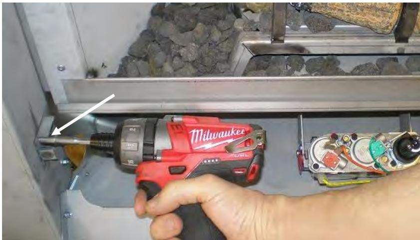
Étape 2 (illustration) : Installez les vis aux coins supérieurs. Fixez les supports de panneau d'accès gauche et droit à l'intérieur du cadre avec les vis DT. Le panneau de façade inférieur ne pourra plus s'ouvrir.
