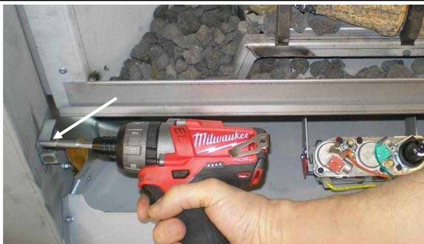
**Étape 3 (illustration) :** Installez les vis aux coins supérieurs. Fixez les supports de panneau d'accès gauche et droit à l'intérieur du cadre avec les vis DT. Le panneau de façade inférieur ne pourra plus s'ouvrir.
