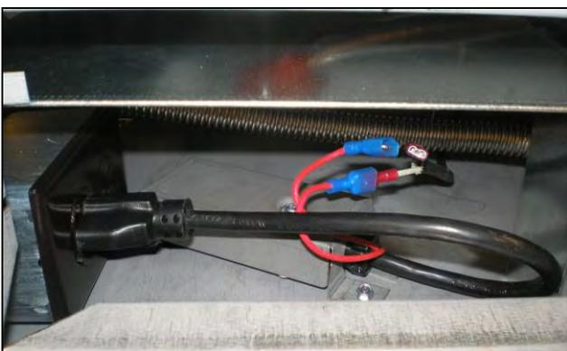
**ÉTAPE 4:** Branchez les fils de l'interrupteur entre le fil de la lampe et le transformateur (voir schéma). Branchez le fil de lampe restant au transformateur. Le transformateur peut alors être branché à la prise et le boîtier peut être fixé au bas du foyer.
