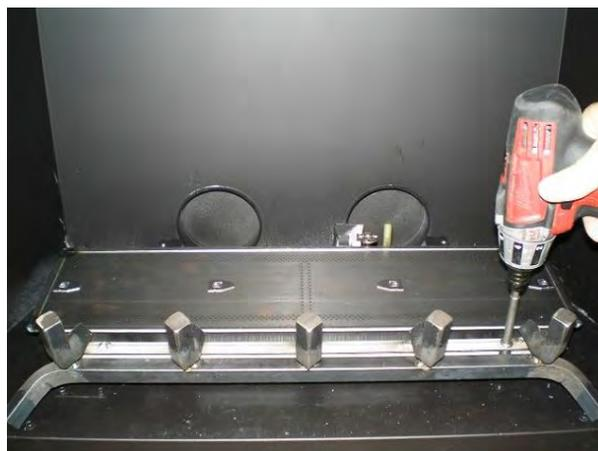
Placez la plateforme pour verre sur le brûleur. Insérez l'écran de veilleuse dans les fentes de la plateforme.
