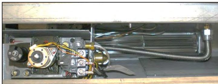
**N.B. : Ne laissez pas les câbles ou fils électriques entrer en contact avec la chambre de combustion ou le dessous du plateau du brûleur.**
