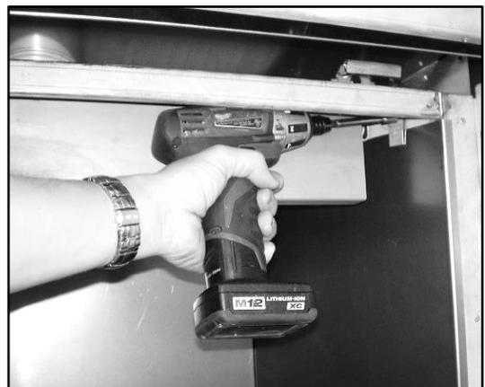
**Étape 4 :** Fixez les doublures latérales en place avec les crochets de retenue.
