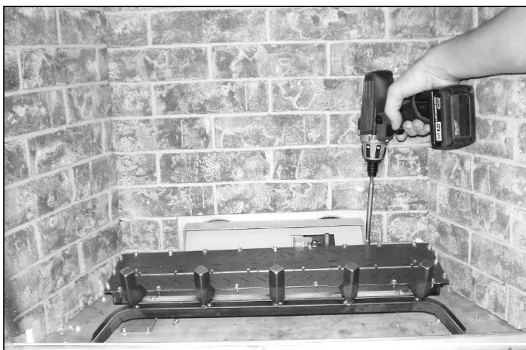
Étape 5 : Réinstallez le support de bûche.
