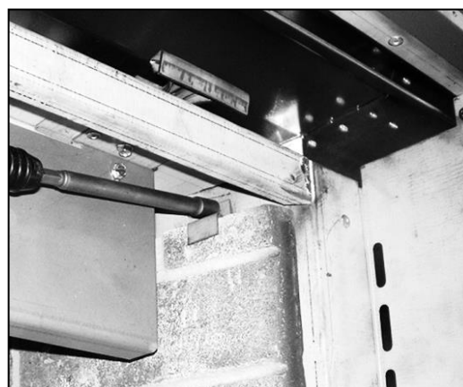
Étape 4 : Fixez les doublures latérales en place avec les crochets de retenue.
