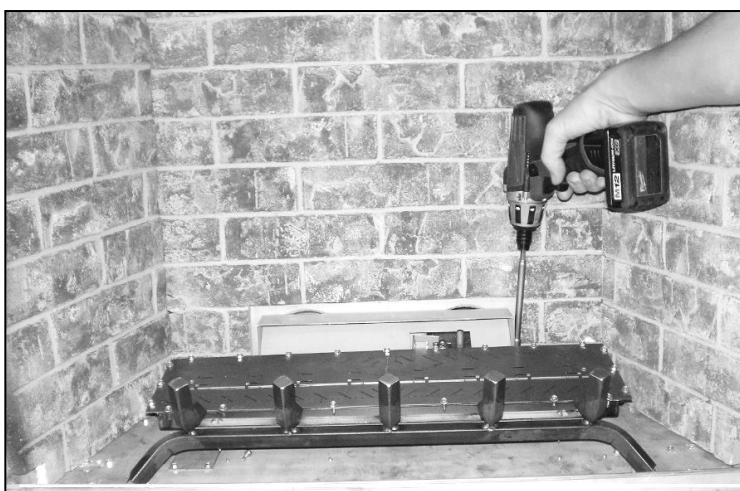
Étape 5 : Réinstallez le support de bûche.
