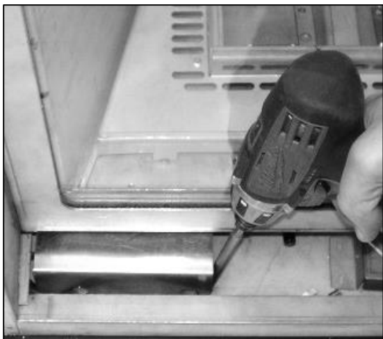
Module de contrôle de l'évent installé dans le foyer .
