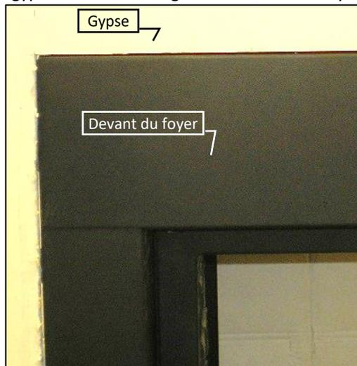
**Étape 3:** Une bordure de brique, tuile, ou autre matériau non combustible peut être installée par-dessus la façade du foyer pour dissimuler le joint.
