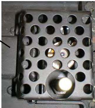
\*L'écran de veilleuse doit être inspecté visuellement une fois par mois pour voir s'il y a signe de détérioration due à l'exposition à la flamme. Remplacez si nécessaire.
