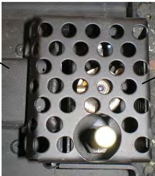
\*L'écran de veilleuse doit être inspecté visuellement une fois par mois pour voir s'il y a signe de détérioration due à l'exposition à la flamme. Remplacez si
