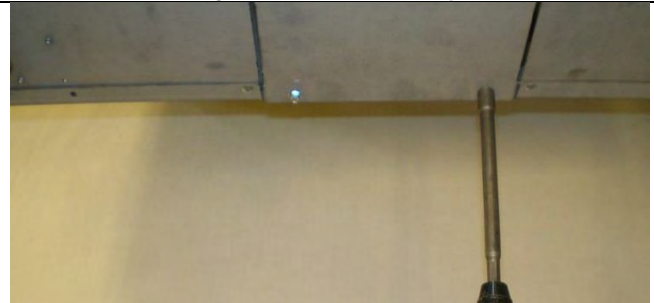
Enlevez les 2 vis du couvercle d'accès du côté opposé au carneau du foyer.
