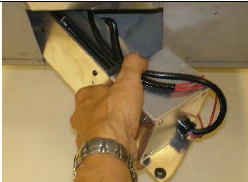
Glissez le ventilateur Z46FK dans l'ouverture.
