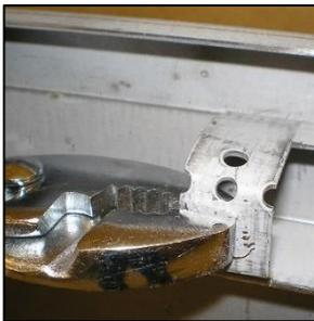
Pliez vers le bas les languettes de l'écran sur le haut et le bas de l'encadrement.
