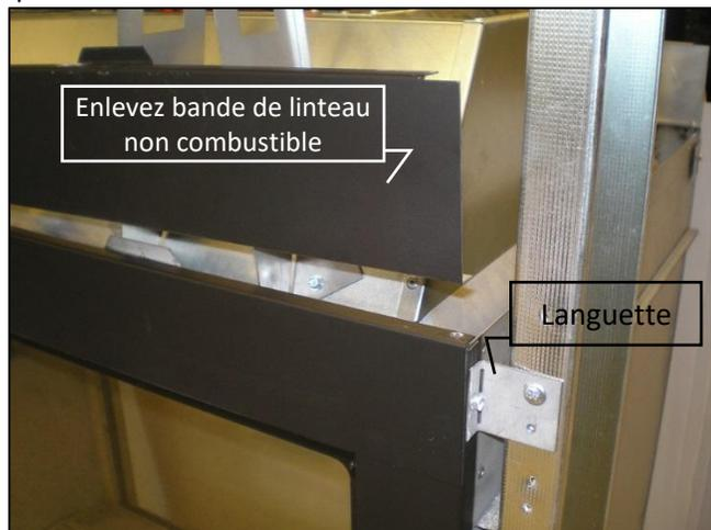
**Étape 2 :** Ne pas utiliser la bande de linteau non combustible au dessus du foyer. Utilisez du panneau de béton.
