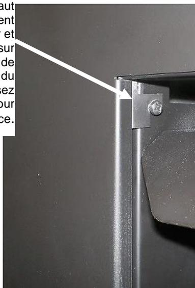
3. Glissez les languettes inférieures de fixation dans le cadre du foyer, sous le support du couvercle d'accès. Insérez les vis et serrez-les. Remplacez le couvercle d'accès.
