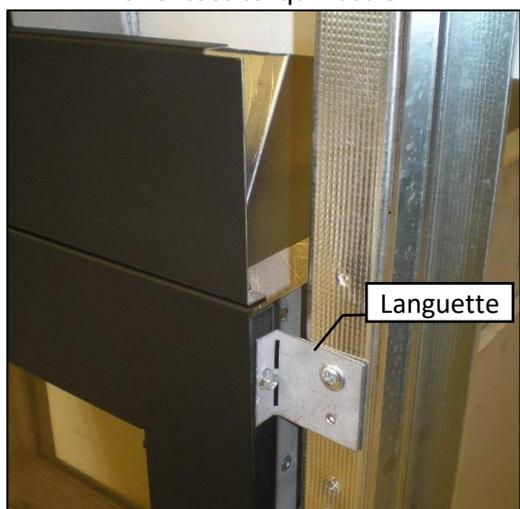
**Étape deux:** Utilisez la bande de linteau non combustible sur le dessus du cadre du foyer et du gypse pour finir le devant du mur. **N.B. : Le gypse doit arriver à égalité du devant du foyer.**
