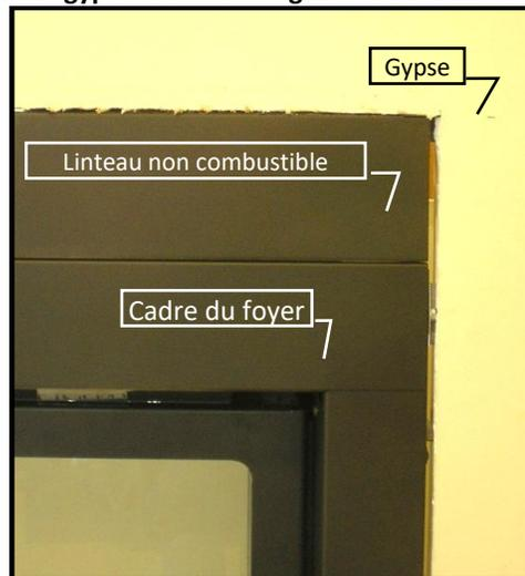
**Étape 3 :** Une bordure de brique, tuile, ou autre matériau non combustible peut être installée par dessus la façade du foyer pour dissimuler le joint.
