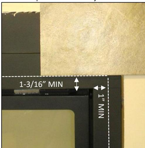
**IMPORTANT!** Si vous installez de la tuile, brique ou autre matériau non combustible autour du périmètre de l'écran : vous DEVEZ laisser 1" de façade découverte autour de l'ouverture du foyer au bas et sur les côtés, et 1-3/16" au-dessus. Ceci permet d'installer et enlever l'écran de sécurité. Voir les illustrations ci-dessous. **Un ensemble de bordure pour tuile est disponible. No de pièce ZCV-TLK.**
