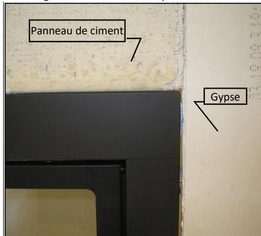
**Étape 3 :** Une bordure de brique, pierre, ou autre matériau non combustible peut être installée sur le mur. Respectez les dégagements de l'ouverture du foyer ci-dessous.
