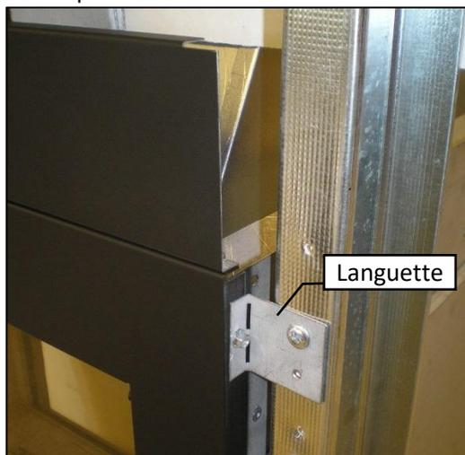
**Étape deux:** Utiliser la bande de linteau non combustible sur le dessus du cadre du foyer et du gypse pour finir le devant du mur. **N.B. : Le gypse doit être à égalité du devant du foyer.**
