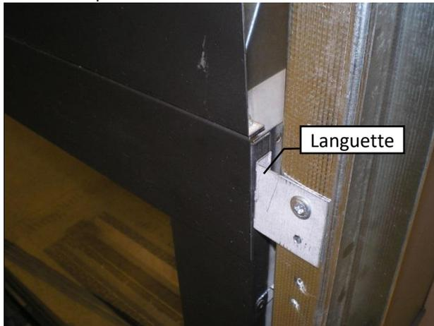
**Étape deux:** Utilisez du panneau de béton pour couvrir la façade du foyer. **N.B. :** L'ensemble pour tuile ZCV-TLK est offert en option. Respectez les dégagements illustrés. Voir les illustrations ci-dessous.
