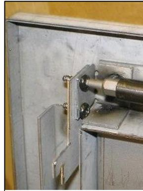
Installez les crochets supérieurs et les languettes inférieures.
