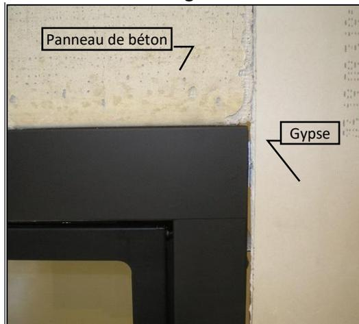
**Étape 3 :** Une fois le mur fini, l'écran avec l'encadrement peuvent être installés. L'encadrement cachera les rebords du foyer.
