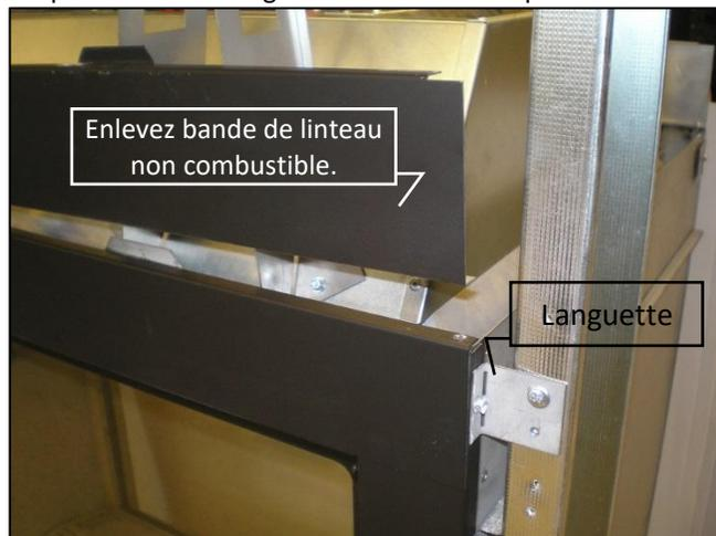
**Étape 2 :** Ne pas utiliser la bande de linteau non combustible au dessus du foyer. Utilisez du panneau de ciment. **N.B. :** Le mur doit arriver à égalité du devant du foyer.
