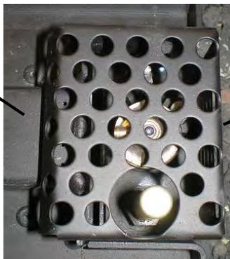
\*L'écran de veilleuse doit être inspecté visuellement une fois par mois pour voir s'il y a signe de détérioration due à l'exposition à la flamme. Remplacez si nécessaire.
