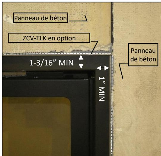
**IMPORTANT!** Si vous installez de la tuile, brique ou autre matériau non combustible autour du périmètre de l'encadrement S2PF2, maintenez un dégagement de 1 po, plus 3/16 po supplémentaire sur le dessus lorsque vous utilisez un écran d'ajustement extérieur.
