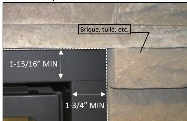
**IMPORTANT! :** Si vous installez de la tuile, brique ou autre matériau non combustible autour du périmètre de l'encadrement : vous DEVEZ laisser 1-3/4" de façade à découvert autour de l'ouverture du foyer au bas et sur les côtés, **plus un 3/16" supplémentaire sur le dessus lors de l'utilisation d'un écran d'ajustement extérieur.** Ceci permet d'installer et enlever l'écran de sécurité. Voir les illustrations ci-dessous. **Un ensemble de bordure pour tuile (ZCV-TLK) est disponible.**
