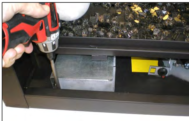
Module de contrôle de l'évent installé dans le foyer .
