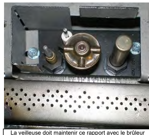
La veilleuse doit maintenir ce rapport avec le brûleur
