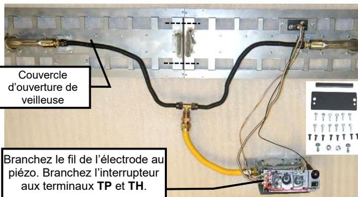
Branchez le fil de l'électrode au piézo. Branchez l'interrupteur aux terminaux **TP** et **TH**.
