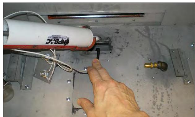
**ÉTAPE 2 :** Insérez les fils de la lampe par le trou d'accès de la chambre de combustion comme illustré ci-dessus. Appliquez du nouveau scellant (Mill-Pac). Fixez la plaque avec des vis.
