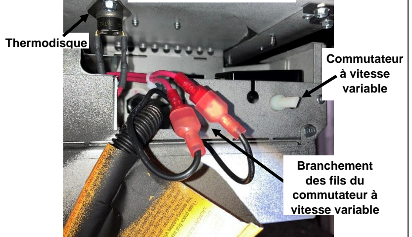
3. Branchez le thermodisque du foyer aux fils du ventilateur avec les connecteurs noirs isolés. Installez le commutateur à vitesse variable et branchez-le avec les connecteurs rouges en plastique.
