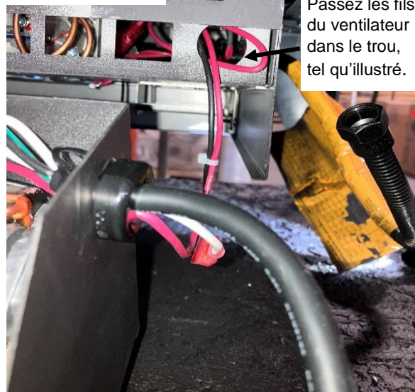
4. Remplacez le couvercle du ventilateur.
