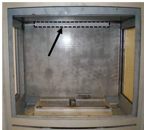
4. La doublure arrière est retenue par l'angle dans le haut du foyer.
