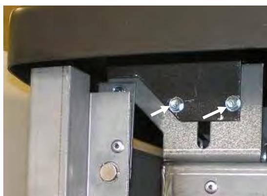
3. Une fois les crochets bien placés, insérez et serrez [1] vis DT dans les supports des côtés supérieurs de la façade du foyer. Remplacez les [2] vis (enlevées à l'étape 1) dans les supports du dessus de chaque côté de l'appareil.
