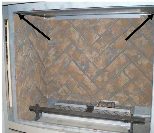
Les doublures latérales sont retenues par les crochets dans les coins supérieurs à l'avant de la chambre de combustion - Voir la page suivante
