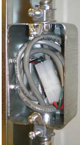
Figure 12 – Réducteur de tension : Si un prolongateur de fil est utilisé, faites la jonction dans une boîte de jonction, tel qu'illustré. Cela réduira la tension et assurera que le branchement ne se sépare pas.
