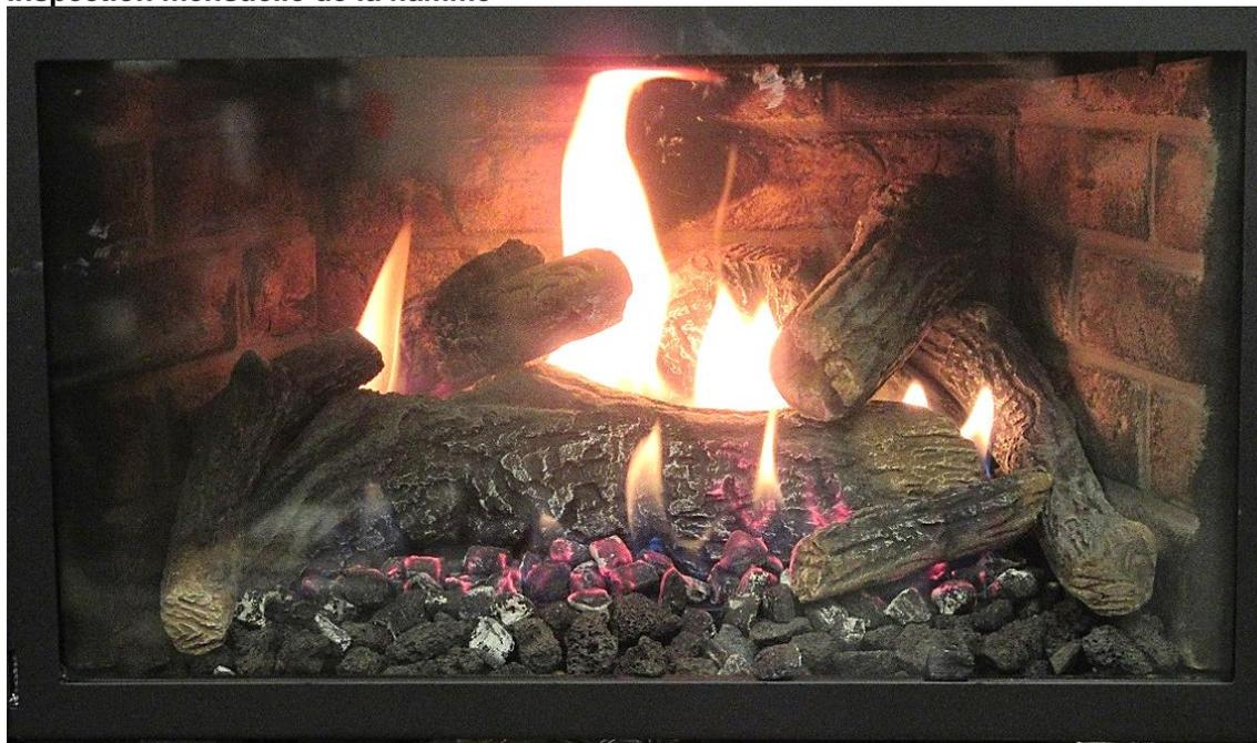
Il est recommandé d'allumer l'appareil au moins une fois par mois et d'en inspecter le patron de flamme pour vous assurer qu'il n'y a pas de problème de tube de brûleur. (Les flammes doivent ressembler à la photo ci-dessus).
