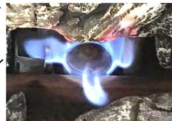
4. Vérifiez que l'allumage du brûleur principal se fait en pas plus de 4 secondes suivant l'ouverture de la valve principale. L'apparence devrait être la même que celle indiquée dans le manuel d'instruction de l'appareil (voir : **Inspection mensuelle de la flamme**). Assurez-vous que l'ouverture d'air primaire n'est pas obstruée.
