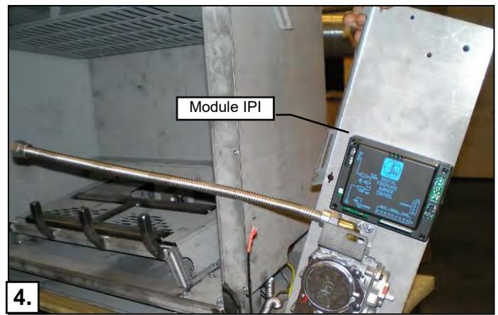
**4.** **Option-** Branchez le flexible (Non-inclus. no de pièce **FP15GC**) du côté entrée de la valve. Il peut être alors branché à l'alimentation en gaz et passé par le canal à l'intérieur du foyer. (voir la section millivolt).
