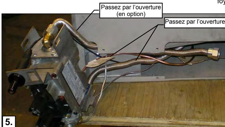
**5.** Passez les branchements de la valve par l'ouverture défonçable.
