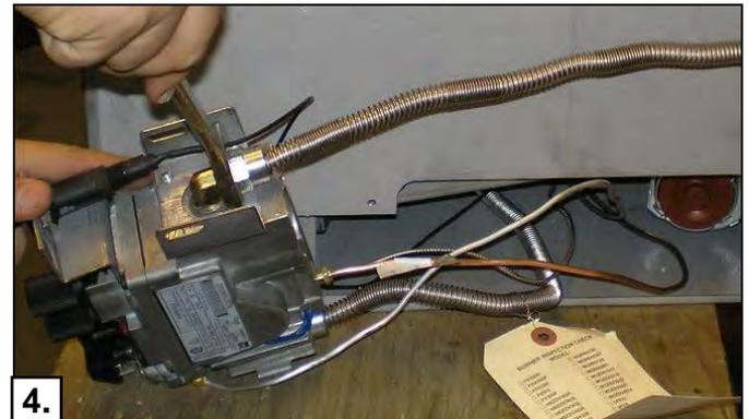
**Option** – Branchez le flexible (Non-inclus. no de pièce **FP15GC**) du côté entrée de la valve. Il peut être alors branché à l'alimentation en gaz et passé par le canal à l'intérieur du foyer.
