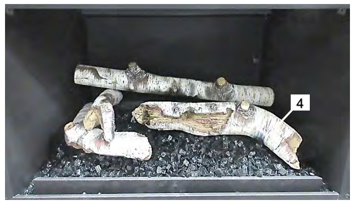
Placez la bûche 4 entre les tubes de brûleur avant et arrière.
