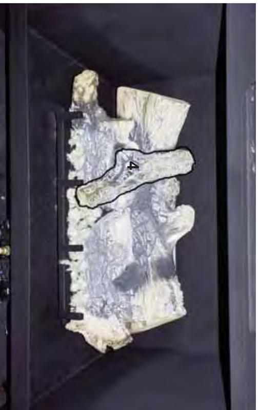
**Étape (4)** Sortez la braise du sac de plastique, cassez la braise en morceaux de la grosseur d'une pièce de 5 cent ou 10 cent et placez-les directement sur le tube du brûleur avant et le tube de croisement. (N.B. ne placez pas de braise sur le tube du brûleur arrière)
