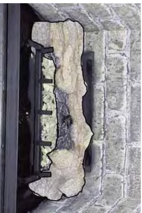
**Étape (4)** Cassez les braises incandescentes en morceaux de la grosseur de l'ongle de votre pouce. Placez les braises incandescentes sur la surface du brûleur avant, sur la surface des plaques de braises et sur le croisement à la même hauteur que les plaques de braise. Hauteur sur le brûleur avant 1/2po à 3/4po. Hauteur sur les plaques de braises 3/4po à 1po. Ne pas bloquer les sorties d'air arrière sur les plaques de braises.
