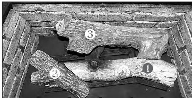
**Étape 4 :** (Remarquez le trou sur la bûche 4, au bas du nœud principal et sur la surface plane près du bout de la bûche). Soulevez la bûche 3 d'environ 2po et placez la bûche 4 sous le nœud du haut de la bûche 3. Positionnez le trou de la bûche 4 sur le lobe de positionnement de la bûche 1, déposez la bûche 3 en place tel qu'illustré. Placez la surface plane de la bûche 4 sur le support de bûche du brûleur arrière gauche et poussez vers l'arrière contre la languette.
