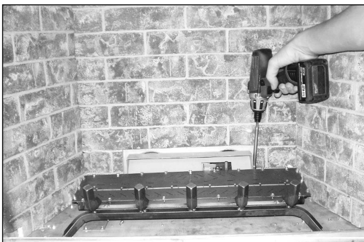
Étape 5 : Réinstallez le support de bûche.
