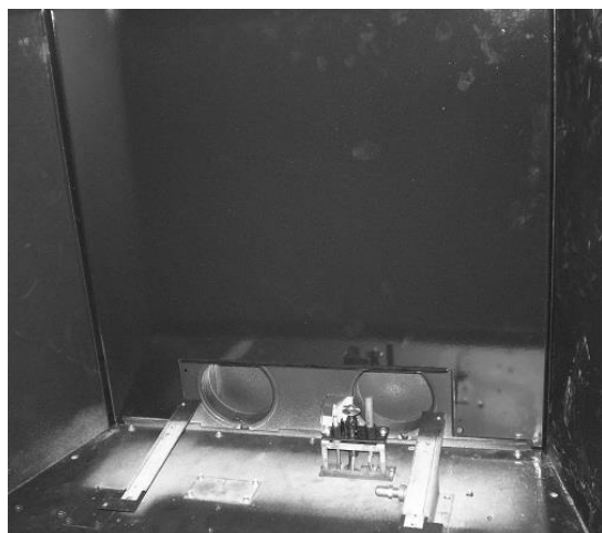
Étape 2 : Placez la doublure arrière contre le mur arrière de la chambre de combustion.
