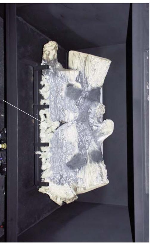
**Étape (4)** Retirez les Braises du sac de plastique, déchirez-les en morceaux de la grosseur de pièces de 1 et 10 sous et placez-les directement sur le tube du brûleur avant et du tube transversal. (NOTE: Ne pas les placer sur le tube du brûleur arrière)
