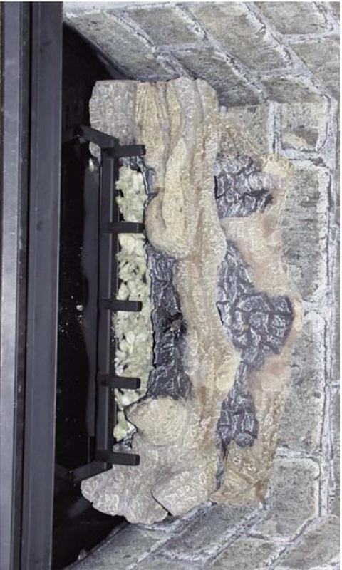
**Étape (6)** Placez la bûche arrière sur un support de bûche à 1/2" de l'arrière du foyer. (Si un chemisage réfractaire est employé, assurez-vous qu'il est installé avant et que la bûche arrière est poussée contre lui le plus possible.)
