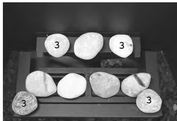
Étape 2 : Placez les roches #3 en position, tel qu'illustré. Ne pas mettre de roche directement sur les tubes du brûleur.
